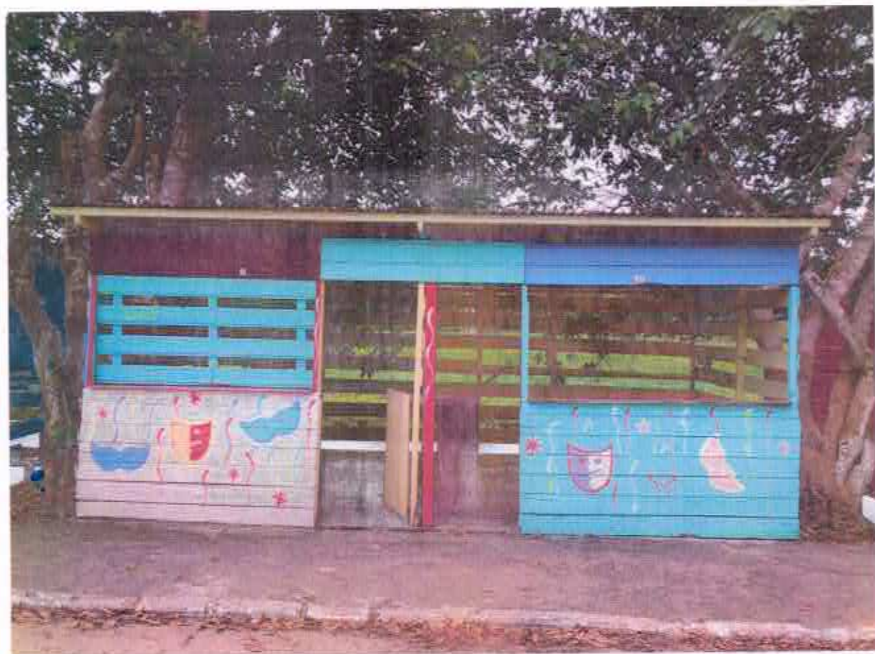
IMAGEM 3: PAREDE NORTE DO IMÓVEL
