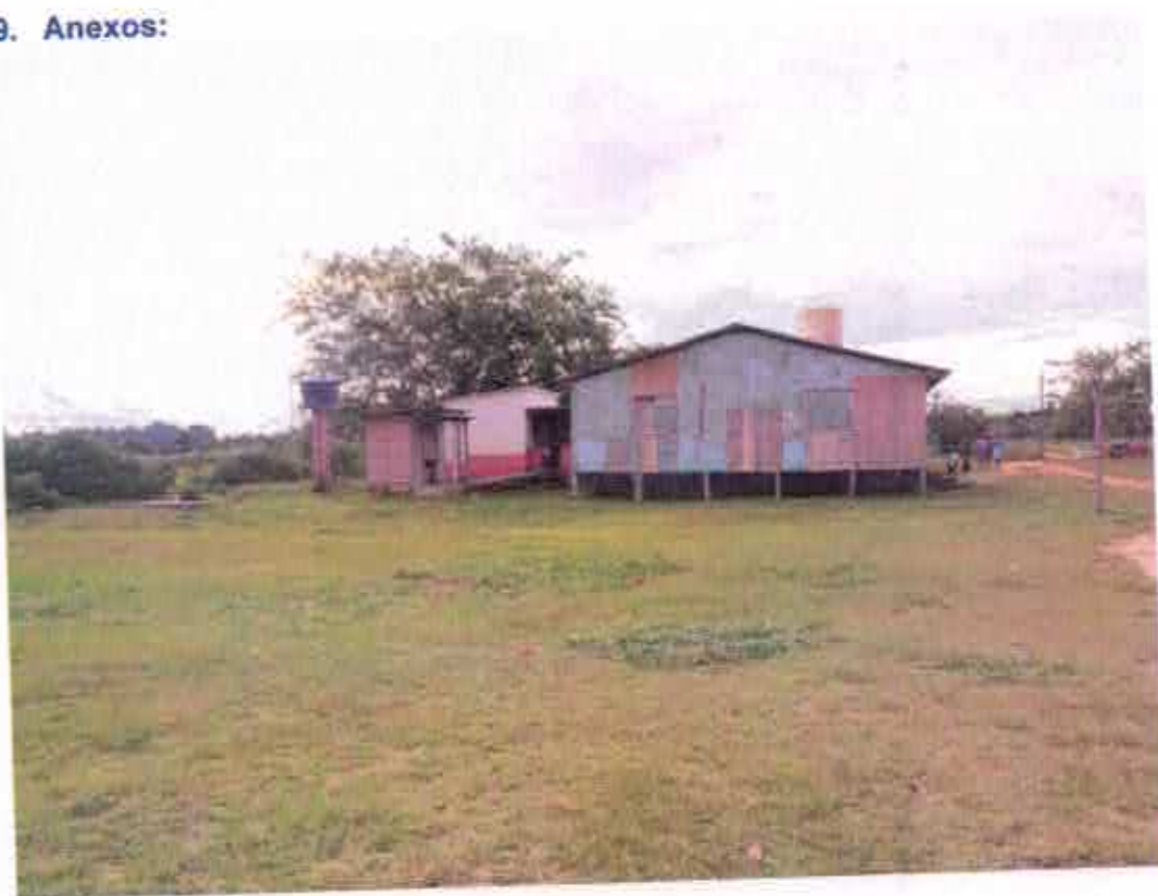
IMAGEM 2: FACHADA NORTE DO TERRENO
