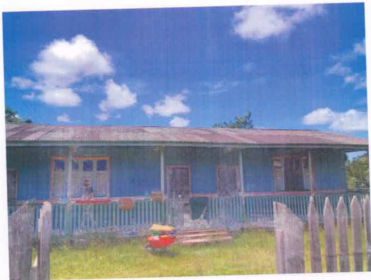
IMAGEM 2: PAREDE OESTE DO TERRENO
