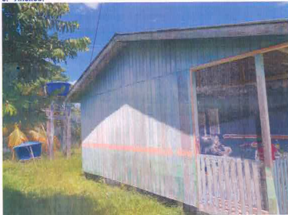
IMAGEM 1: FACHADA NORTE DO TERRENO
